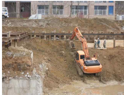
굴착 및 토류판 설치
