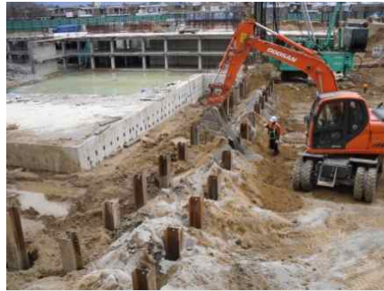
전·후열 말뚝 설치
