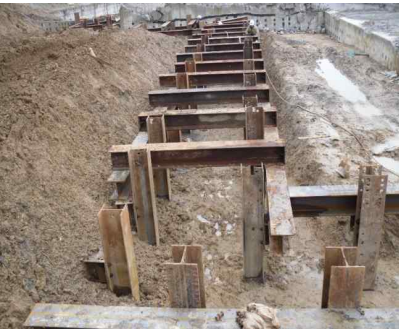
수평 연결재 설치
